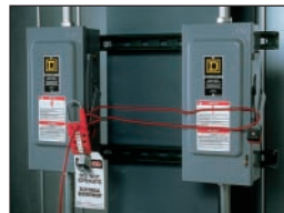
Блокировка отдельных или нескольких размыкателей электроцепи
